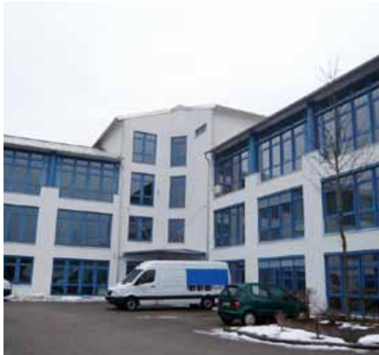
Das mit der Wärmepumpenanlage versorgte Gebäude in Perlach
