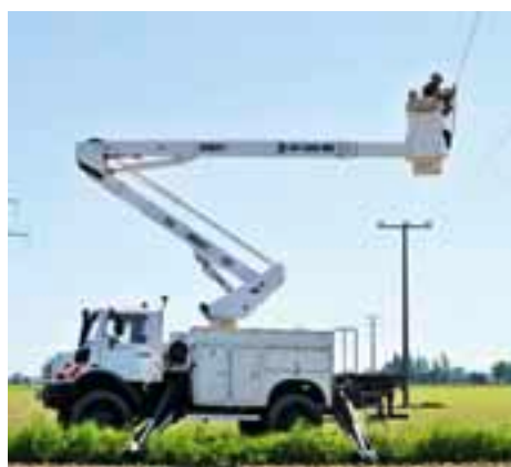
Die Arbeiten-unter-Spannung-Profis vom Bayernwerk in Aktion: Einbau einer 20.000-Volt-Trennstelle
