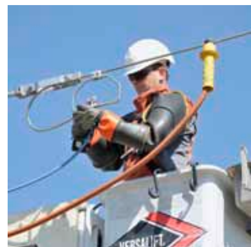
Die Arbeiten-unter-Spannung-Profis vom Bayernwerk in Aktion: Einbau einer 20.000-Volt-Trennstelle
