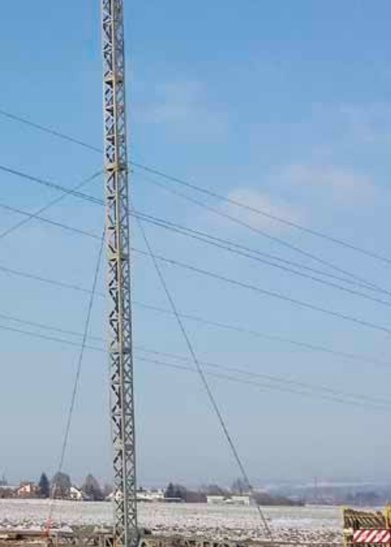
Auf dem knapp 13 Kilometer langen Bauabschnitt zwischen Rottersdorf und Sand stellt das Bayernwerk derzeit neue Masten auf.
