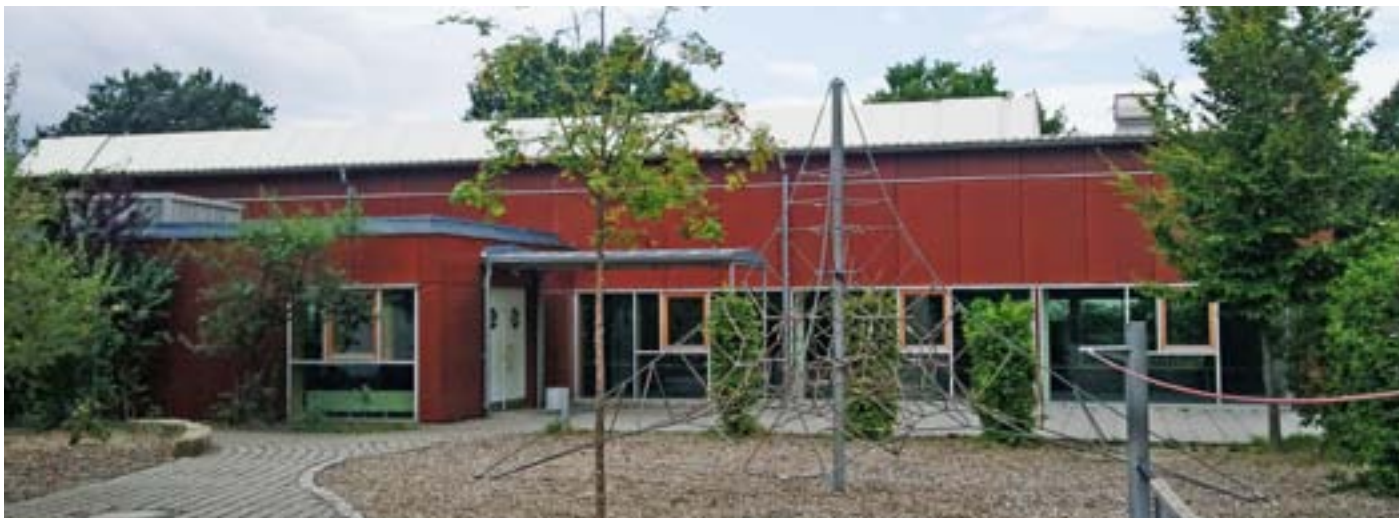
Die Mehrzweckhalle in Kirchseeon wird durch ein Mini-BHKW versorgt.
