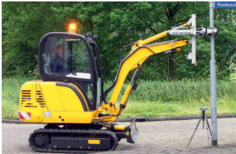
Mit Mini-Bagger und Hightech-Prüfgerät testet E.ON Bayern, ob der Mast weiterhin standfest ist
