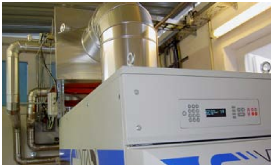
Klein, leise und gut für die Umwelt: Die Mikroturbine in Piding leistet zuverlässig ihre Dienste.
