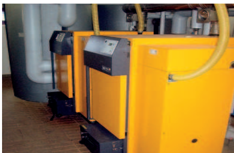
Das alte Heizsystem wurde durch Pelletkessel ersetzt
